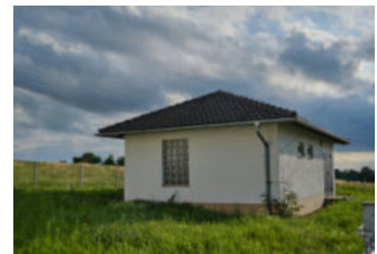
Das Dach auf dem Gebäude der Drucksteigerung soll erneuert und vergrößert werden
