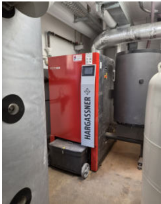
Die neue Heizung ist installiert
