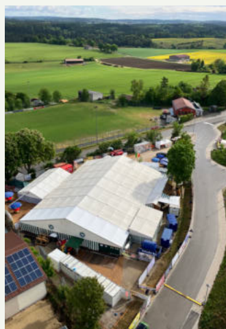
Tolle Aussicht vom Autokran über das Zelt und weit darüber hinaus
