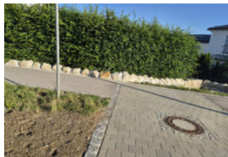
Wasserbausteine am Radweg
