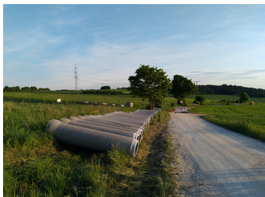
Beginn der Arbeiten - Kanalrohre zum Regenrückhaltebecken
