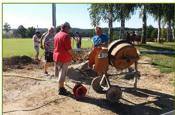
Projektleiter Thomas Klameth und Bernhard Schimmer an der Betonmaschine
