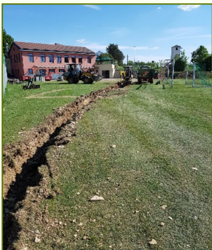
Christian Herzog beim Ziehen der Gräben für die Stromversorgung
