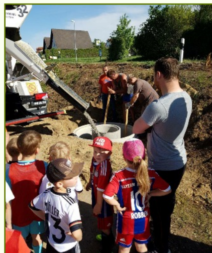
Setzen eines Betonrings für die Flutlichtmasten unter genauer Beobachtung der Kids
